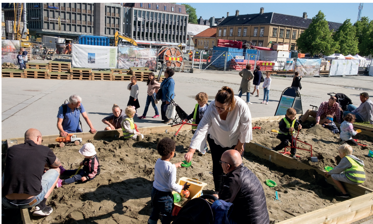
Bygging på Torvet med både store og små gravemaskiner. Foto: Carl-Erik Eriksson/Trondheim kommune
