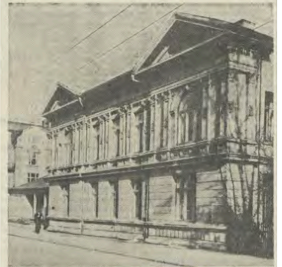
Josefinegate 34 som nå skal bli Arkitektenes Hus . Fasaden ut mot gata blir ikke endret, men innvendig vil huset bli totalt forandret.
