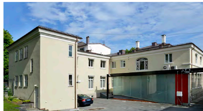
Oscars gate 29, ombygd inngangsparti, ny utgang, gjennmuring av vindu, revet adkomst til bitrapp, 2002. Foto: XK Entreprenør.
