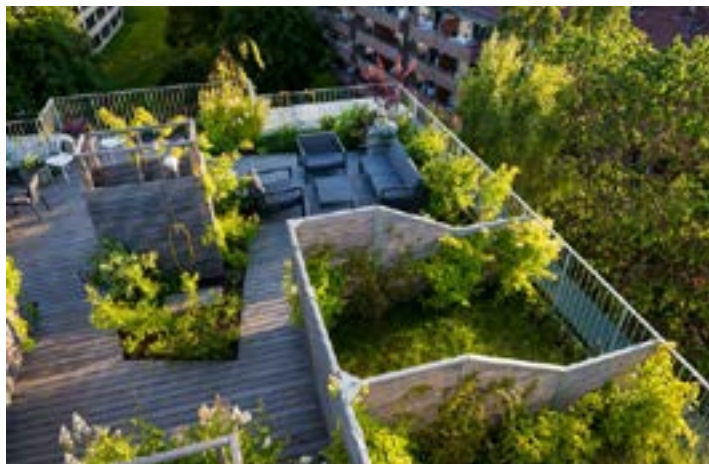
Dælenengata 10 - Ved etablering av takterrasse må den sikres gode oppholds-kvaliteter, som vind- og solavkjøring og varierte soner for opphold. Tykkelsen på vekstlaget avgjør hva som kan plantes/dyrkes på taket.
