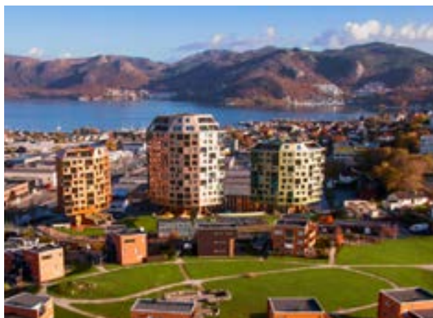
Rundeskogen, Sandnes, Helen og Hard Arkitekter. Frittliggende punkthus formgitt for utsyn og for å minimere fotavtrykk på bakken.
