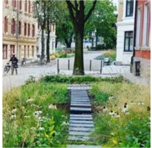
Deichmanns gate, Oslo. Omgjøring av gate til grønn og trafikktrygg gangforbindelse.
