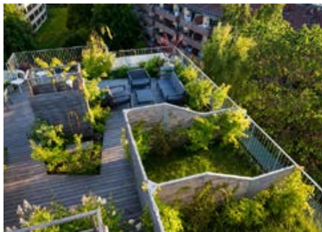
Dælenengata 10 - Etablering av takterrasse der solforholdene er gode, kan supplere utearelene der det er dårlige solforhold noen tider eller tidpunkt på.
