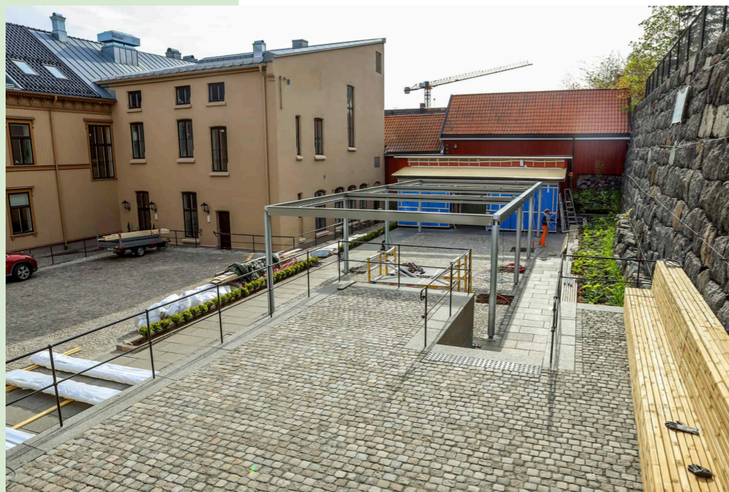
Pergolaen nærmer seg ferdig.
