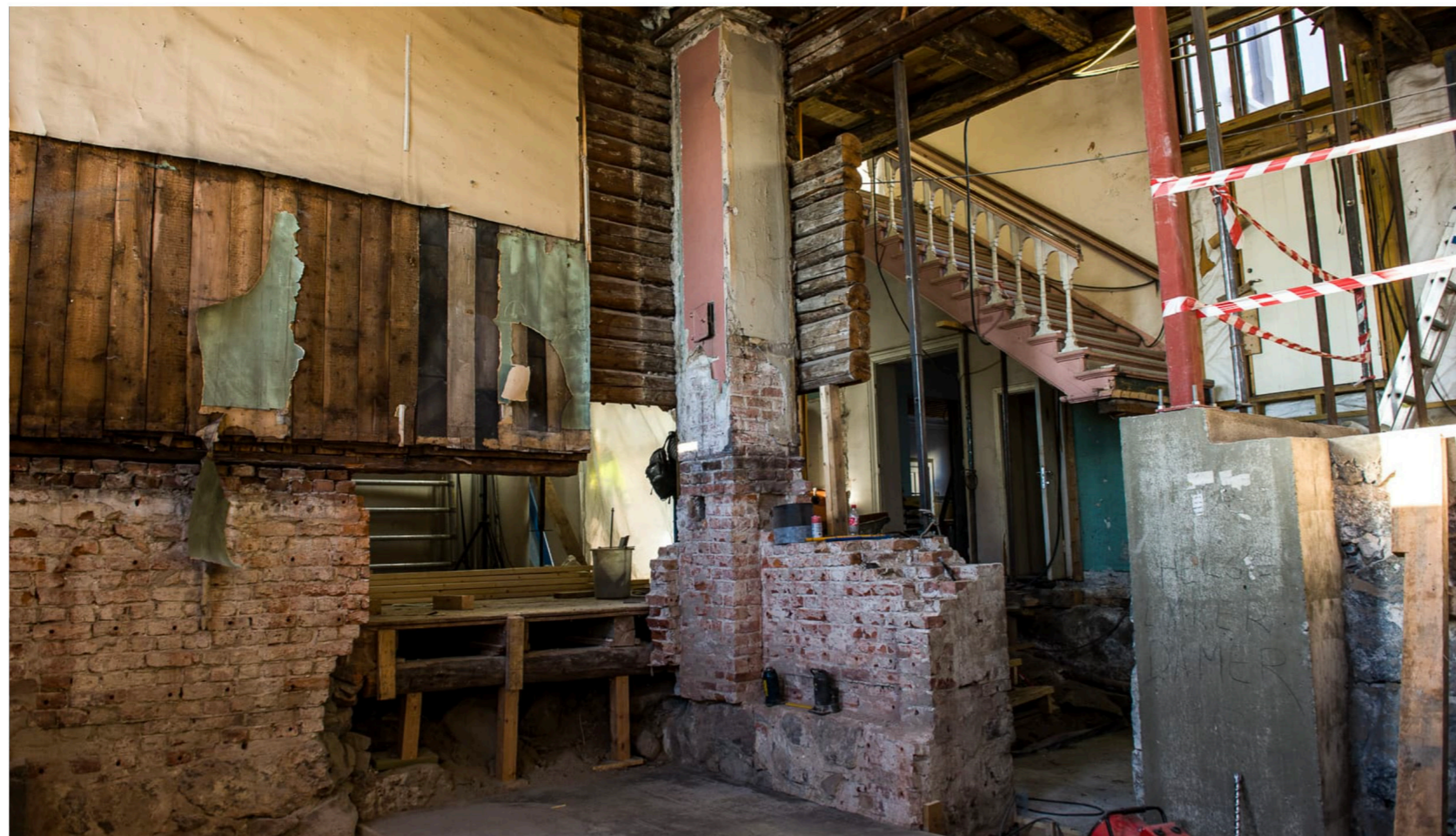
Bildet er tatt fra kjelleren opp mot der inngangen fra Storgata kommer. Trappa opp til Festsalen er delvis demontert og skal settes i stand.
