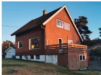
HILDES HUS PÅ NESODDEN: Bygget i 1962. Tilstand i 2020
