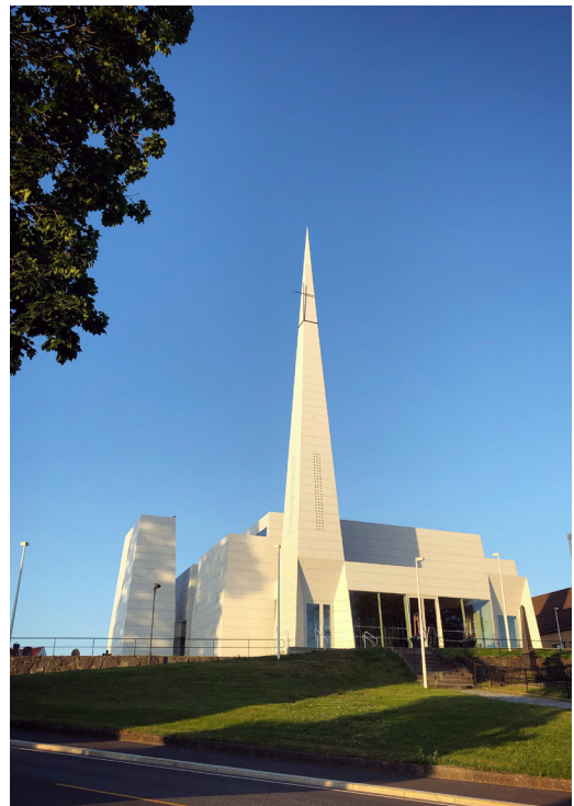
Østre Porsgrunn kirke. Arkitekt: Espen Surnevik. Foto: Elise Brændaa
